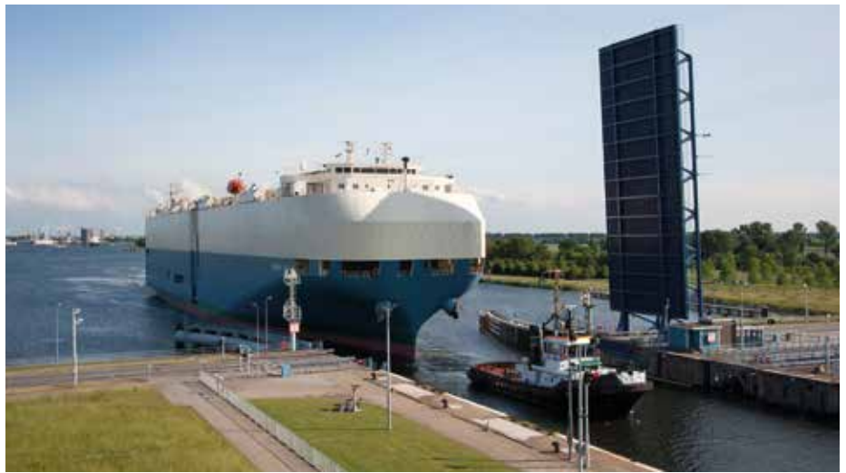
De huidige sluis in Terneuzen
